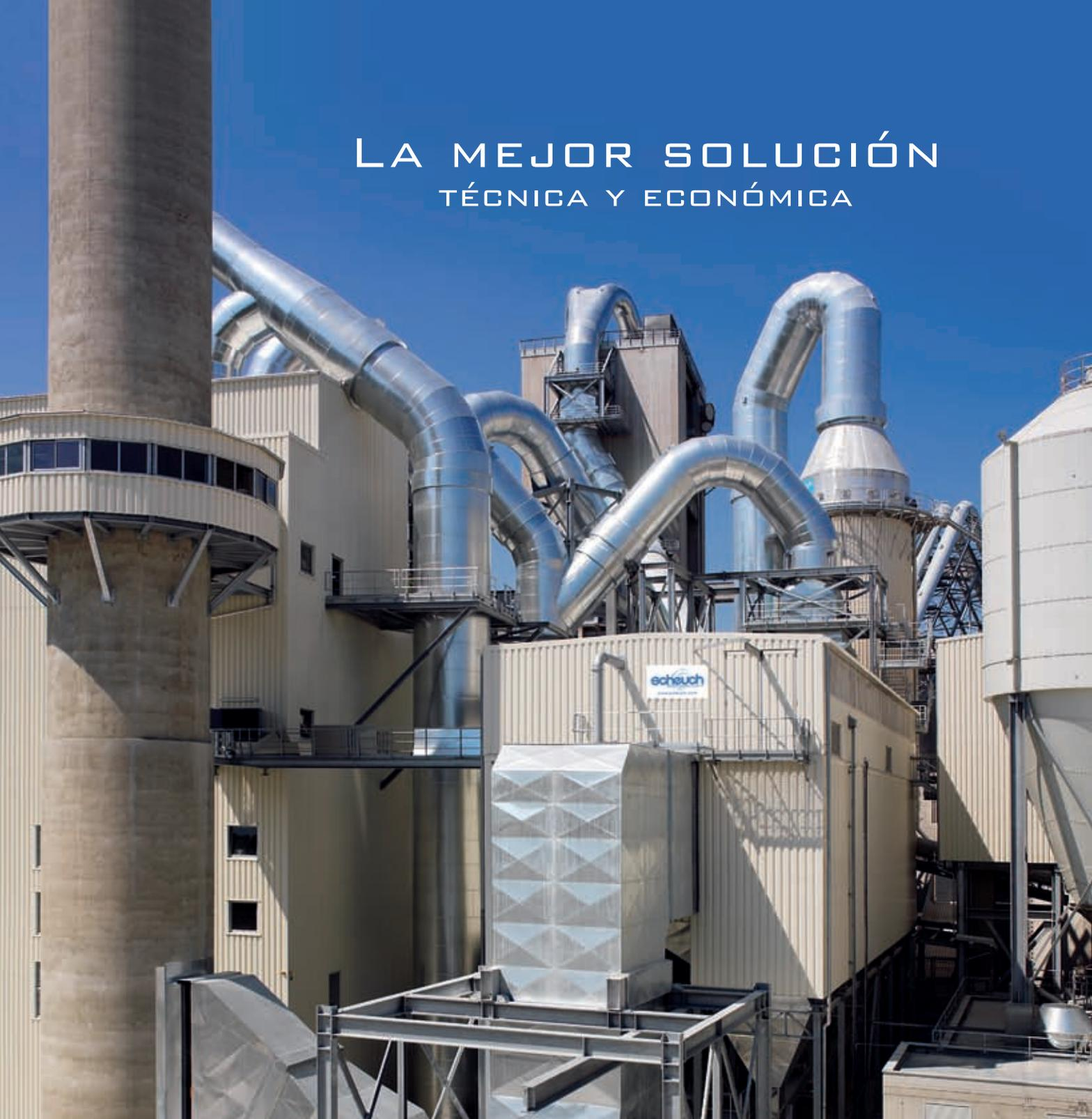
■ Merced a nuestra larga experiencia en la construcción de instalaciones conocemos exactamente los requerimientos y procesos de la fabricación de cemento y ofrecemos instalaciones desempolvadoras fiables y eficientes para todo el proceso de producción, desde la cantera hasta el transporte de cemento. La tecnología patentada EMC ha redefinido, por ejemplo, el estado de la técnica en instalaciones de filtrado de mangas.
